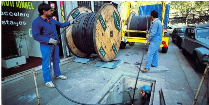
Tirage de câbles pour un réseau de vidéocommunications
