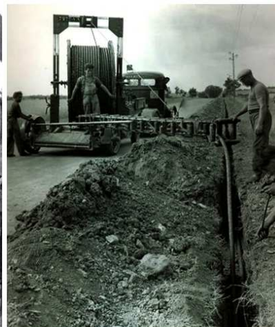
Pose d'un câble coaxial dans les années 1950
