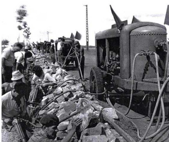
Creusement d'une tranchée au marteau piqueur (années 1960)
